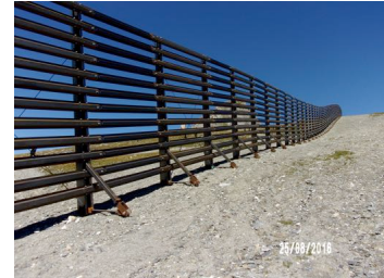
Fig. 9 - Vista dell'intervento con strutture per il controllo del trasporto eolico eseguito a Triebsschneew d Niederalp - Steiermark (A)
